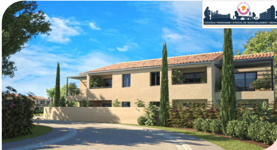
Résidence Les Vignètes - Lignan sur Orb 8 Logements Collectifs
