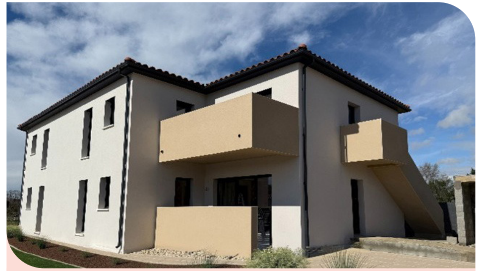
Résidence Vilanova - Villeneuve-lès-Béziers 4 Logements individuels - 4 T4 Livraison Octobre 2025
