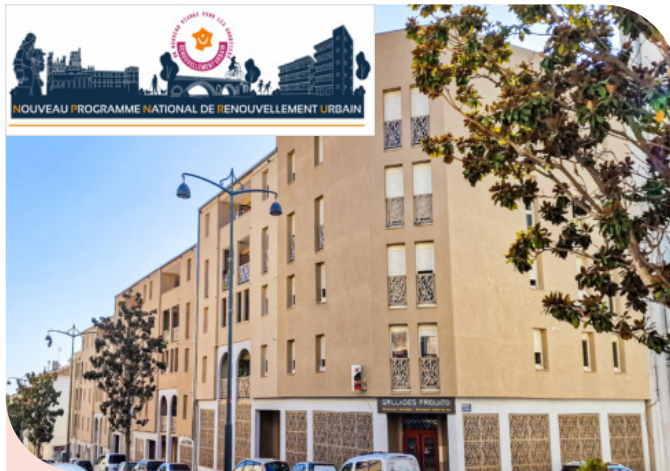
Résidence Gambetta - Béziers 215 Logements Collectifs - 312 053 € TTC
