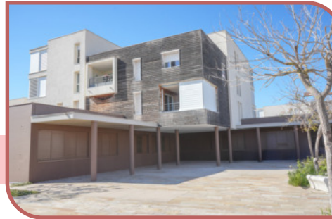
Livraison de 4 Logements Résidence Le Gasquinoï 2 - Béziers
