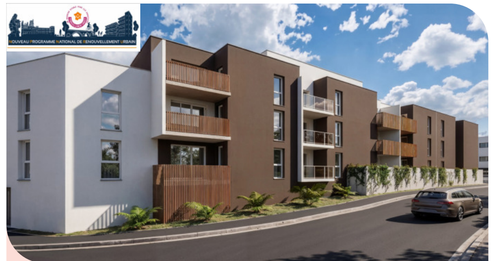
Résidence Le Serpolet - Béziers 38 Logements Collectifs
