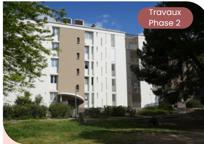
Résidence Iranget- Béziers 602 Logements Collectifs - 2 901 116 € TTC
