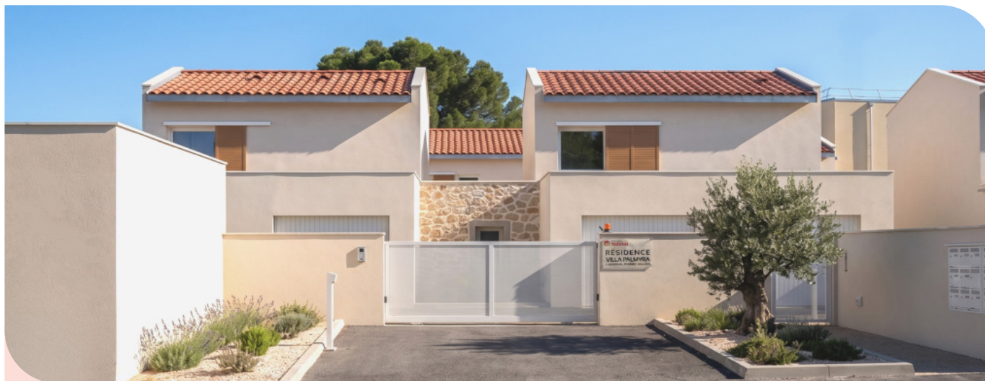
Résidence Villa Palmyra - Béziers 13 Logements individuels - 4 T2, 5 T3, 4 T4 Livraison Décembre 2025
