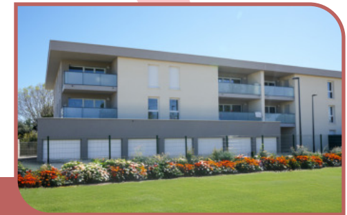
Livraison de 50 Logements Résidences La Plume et Le Rollier Villeneuve-lès-Béziers
