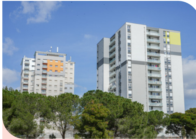
Résidences Tour 1 & Tour 3 - Béziers 88 Logements Collectifs
